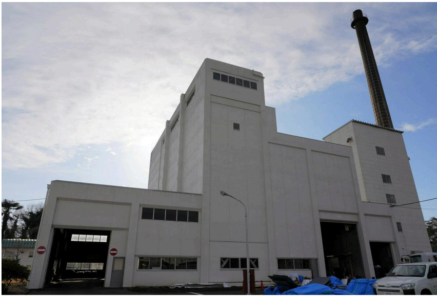
稼働から50年が経った塩釜市清掃工場。市内の可燃ごみを焼却する=2026年3月10日午後3時36分、宮城県塩釜市杉ノ入裏、浅田朋範撮影
