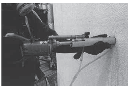
アスベスト対策状況 削孔による粉じんの飛散抑制 （仮設工事：壁つなぎ削孔）
