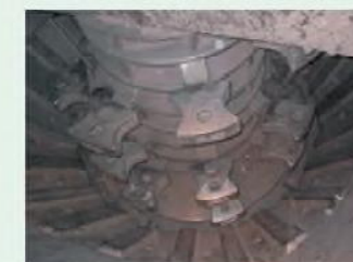
破碎機の内部
