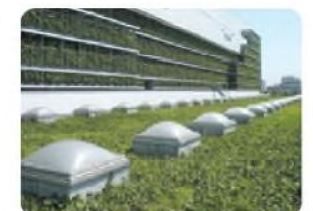
壁面緑化(板橋清掃工場)
