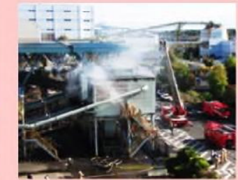
粗大ごみ破碎処理施設での火災
