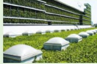
屋上緑化(板橋清掃工場)
