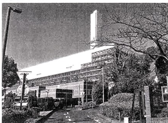
30年度に改築を予定していた板橋清掃工場 17日
