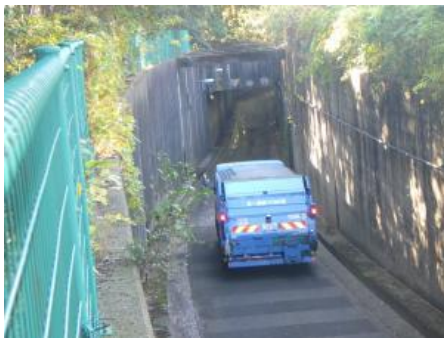
専用道路のトンネル部（通常時）
