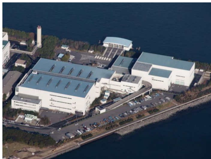
京浜島不燃ごみ処理センター
