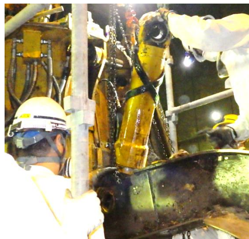
油圧シリンダ交換作業
