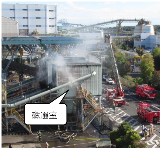
消火中の状況
