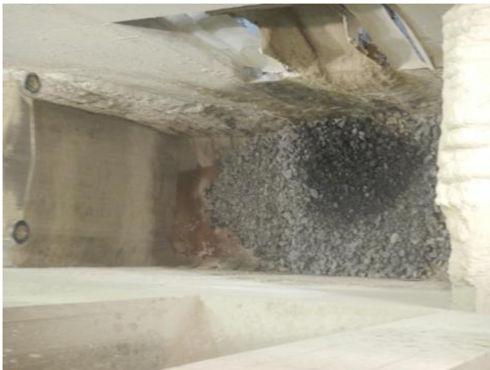
【写真1】割栗石敷設
