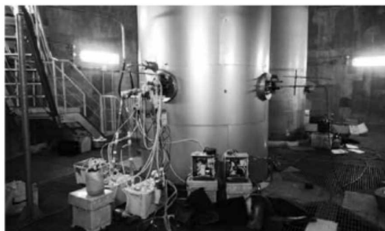
第三者機関による排ガス測定の状況（杉並清掃工場）
