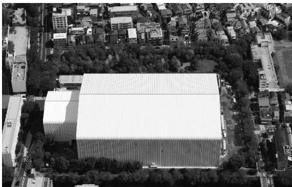
全覆い仮設テント（令和元年9月撮影）
