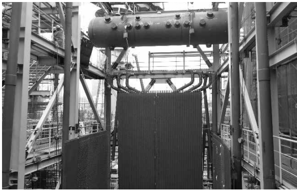
ボイラドラム設置状況
