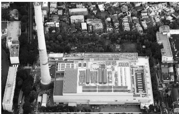
【新】目黒清掃工場建設状況（令和4年8月撮影）
