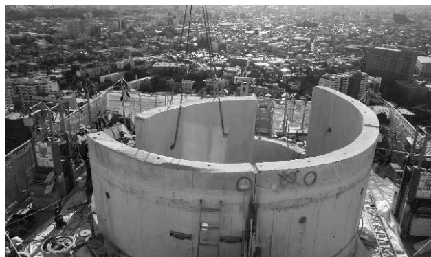
煙突外筒解体状況
