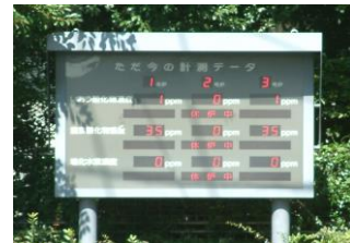
【排ガス状況表示盤】
