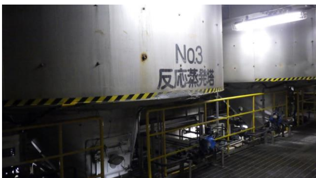
排ガス処理設備
