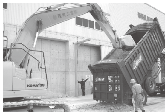
図6 焼却灰のかき出し作業
