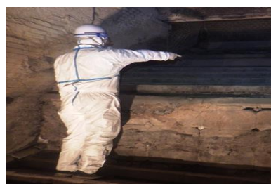
焼却炉内点検の様子
