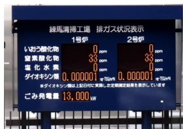
排ガス状況表示盤
