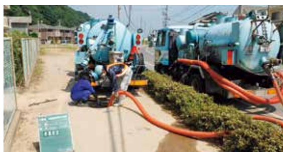
日本下水道管路管理業協会による清掃作業
