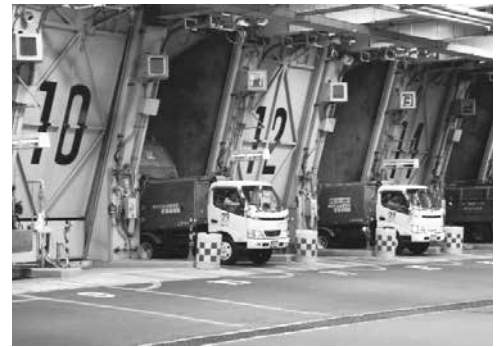
ごみの搬入の様子（足立清掃工場）
