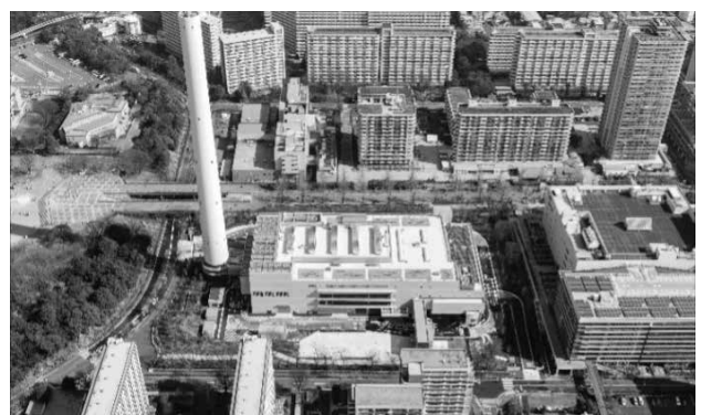
【新】光が丘清掃工場（令和3年3月しゅん工）
