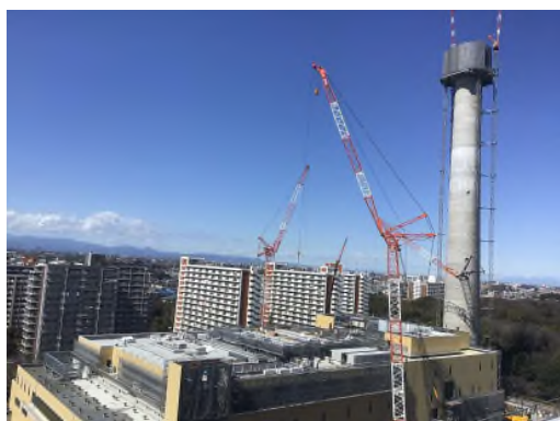
【建替工事(光が丘清掃工場)】
