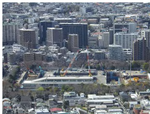
【建替工事(目黒清掃工場)】
