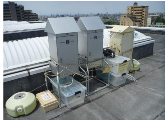
【測定器 (江戸川清掃工場屋上)】
