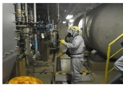
アンモニア漏洩対応訓練の様子
