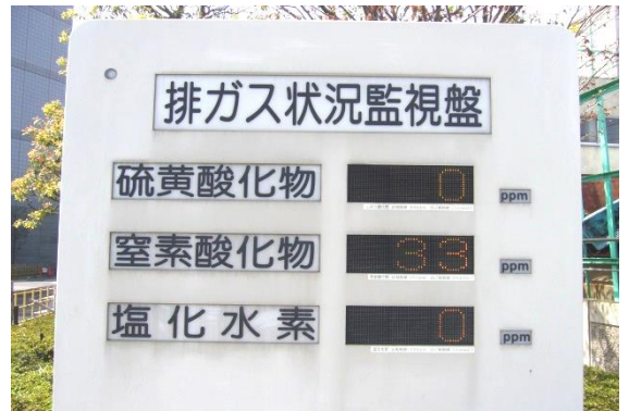
排ガス状況監視盤
