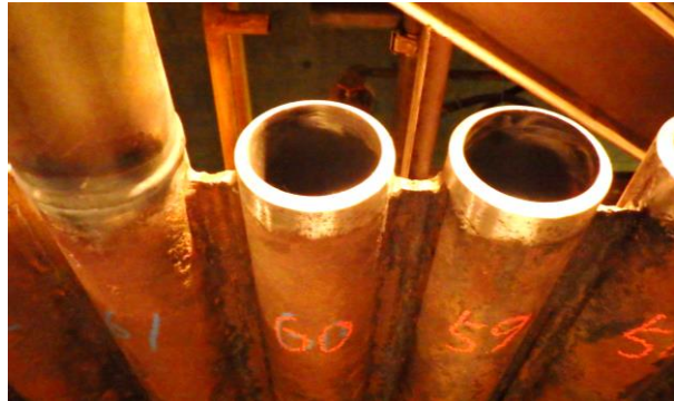
(右写真) 抜管箇所拡大写真です。切り取った部分に新しい水管を溶接で接続します。
