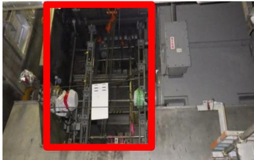
（左写真）誘引ファンは工場地下部に設置しています。赤枠内が回転数制御装置の設置場所です。装置の設置場所や大きさなどで、工場建物の外に搬出するだけでも重労働です。
